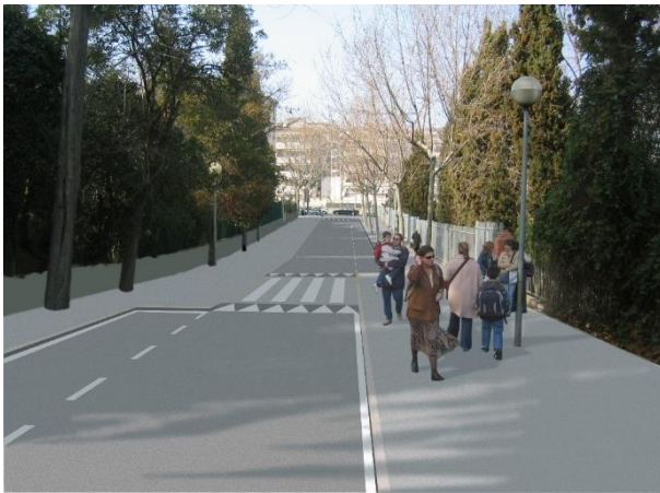
Imatge 110 Carrer amb sentit únic i aparcament alternatiu, que permet l'ampliació de voreres
