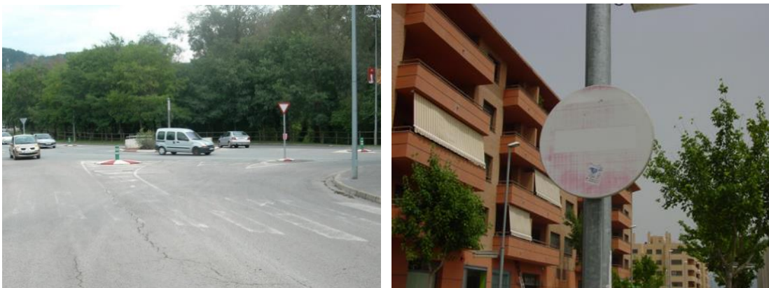
Imatge 101 Senyalització en estat deficient
