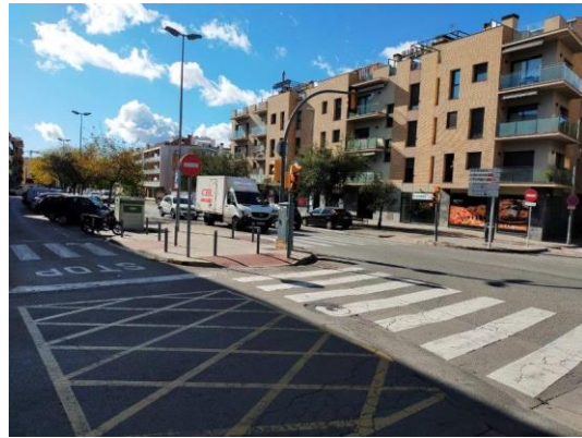
Imatge 9 Intersecció amb passos de vianants, STOP i quadrícula, a la Carretera Nova.
