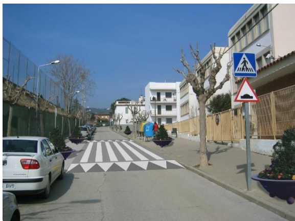
Figura 81 Fotomuntatge proposta de carrer amb paviment únic i preferència per a vianants. Velocitat límit de 20 km/h.
