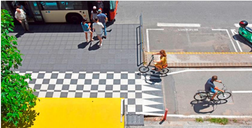
Imatge 109 Exemple de carril integrat a Barcelona. Plataforma per accedir l'autobús i integració del carril pedalable. Solució de Zicla, Sistema Vectorial.
