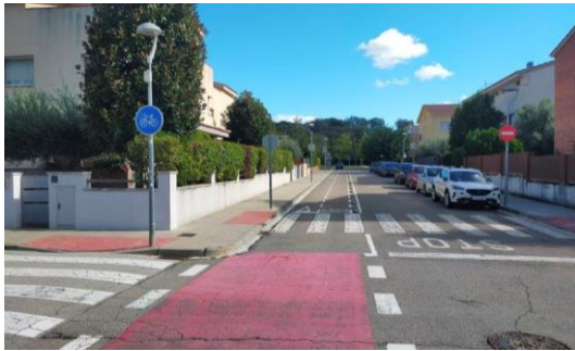
Imatge 33 Carril bici segregat al carrer de l'Abadessa Emma.
