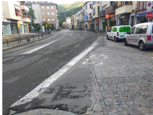
Imatge 76 Cruïlla sense pas de vianants al carrer de Can Noguera i asfalt en mal estat.
