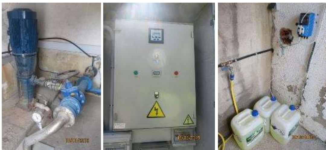
Figura 12. Bombeig, telecontrol i cloració dipòsit Plaça de les Aigües
