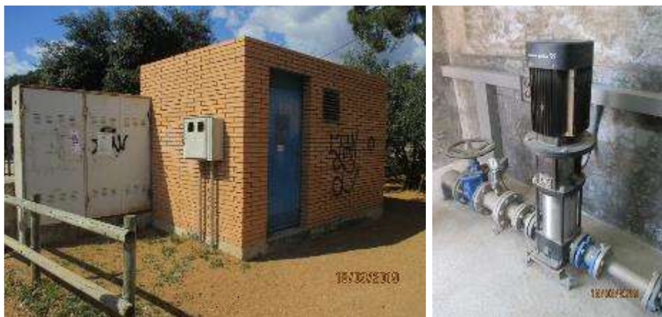
Figura 18. Exterior i bomba. Estació Elevadora Alpe
