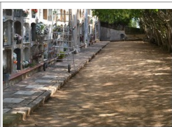
Vorera de rajola ceràmica i part central sense pavimentar
