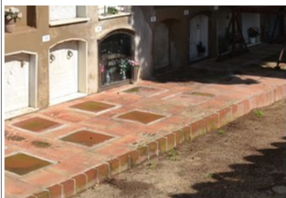
Vorera de rajola ceràmica i part central sense pavimentar
