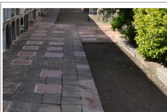
Vorera de rajola ceràmica i part central sense pavimentar
