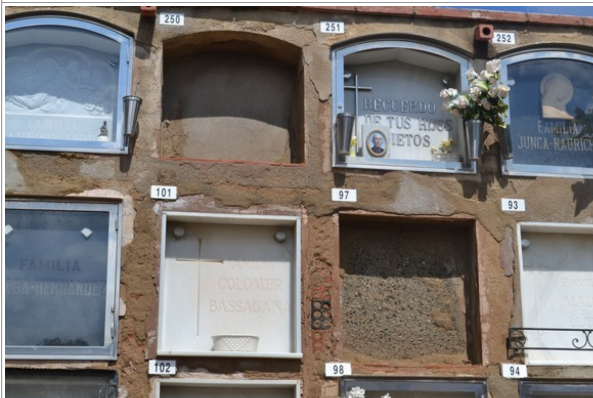
Escrostonaments i desprendiments de revestiment
