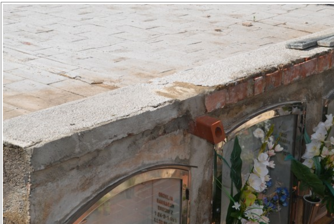
Detall de gàrgola i despreniment de peça ceràmica frontal
