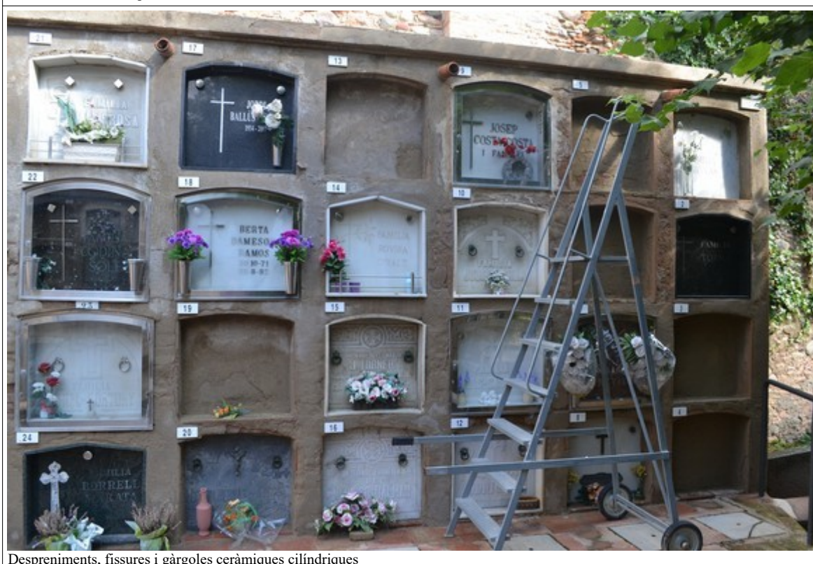
Humitat i verdet a la part inferior en revestiment envellit
