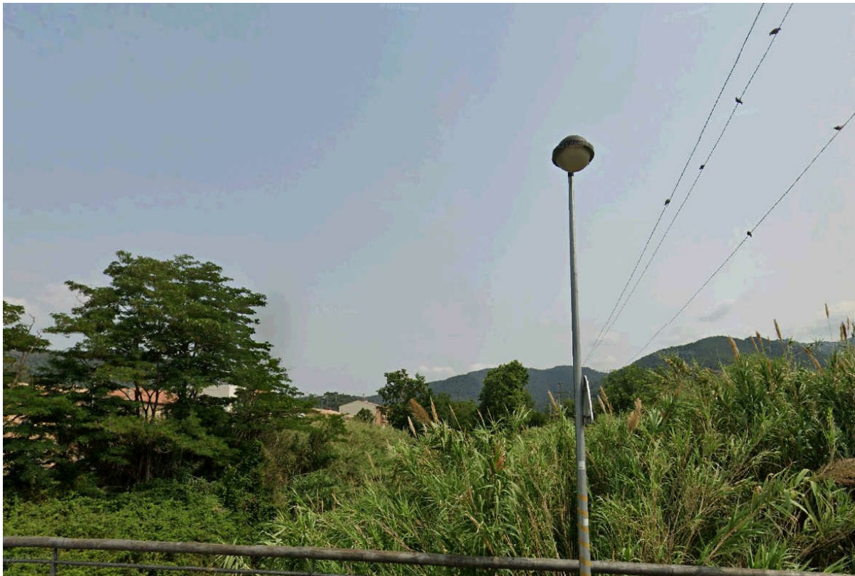
Imatge 2. Detall de l'àmbit d'actuació, vista des del pont del carrer Moranta
