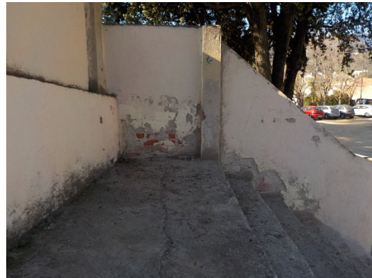
Detall del mur de tancament del carrer Pere Ballús a enderrocar.
