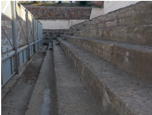
Vista parcial de la grada sud a enderrocar.
