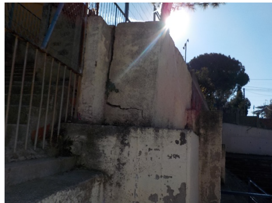
Detall del mur a reparar amb el pi a arrencar.
