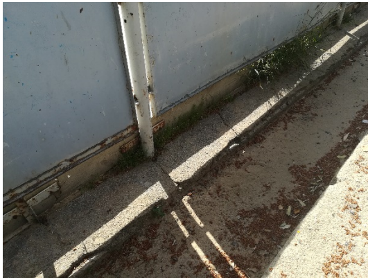
Detall tanca perimetral pista a enderrocar.
