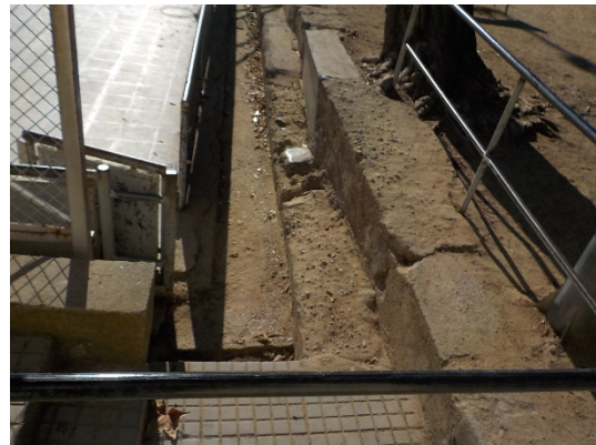
Detall muret perimetral a sanejar.
