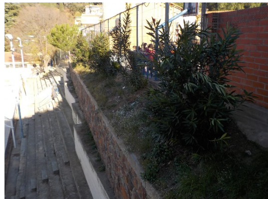
Vista de mur de contenció i elemnts de jardineria, limit est.
