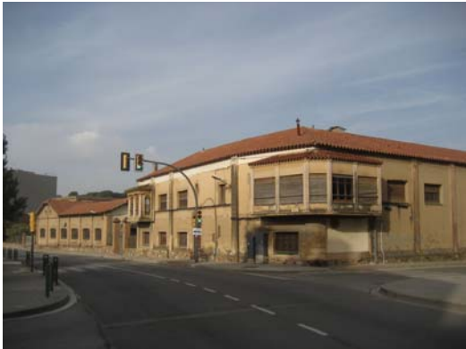
Foto 1. Vista de la parcel·la des de la carretera Nova.
