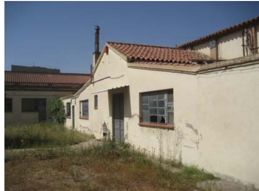
Foto 22. Pati on s'ha realitzat l'assaig P2 i on es poden veure les edificacions auxiliars a enderrocar i reformar.
