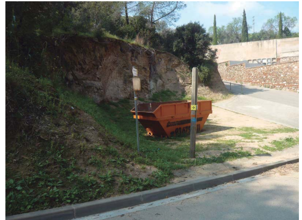
ADEQUACIÓ DE LA URBANITZACIÓ EXTERIOR DEL CONJUNT MONUMENTAL DE LA DOMA A LA GARRIGA ref. 1606
