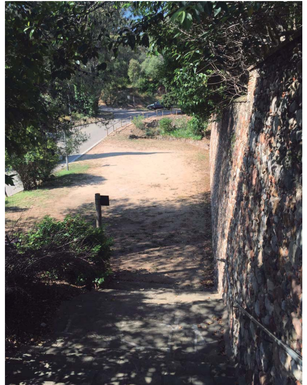
ADEQUACIÓ DE LA URBANITZACIÓ EXTERIOR DEL CONJUNT MONUMENTAL DE LA DOMA A LA GARRIGA ref. 1606
