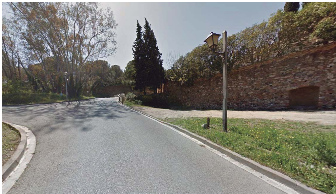
ADEQUACIÓ DE LA URBANITZACIÓ EXTERIOR DEL CONJUNT MONUMENTAL DE LA DOMA A LA GARRIGA ref. 1606
