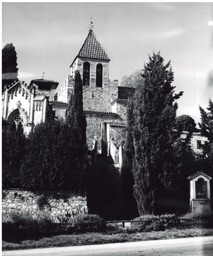
ADEQUACIÓ DE LA URBANITZACIÓ EXTERIOR DEL CONJUNT MONUMENTAL DE LA DOMA A LA GARRIGA ref. 1606
