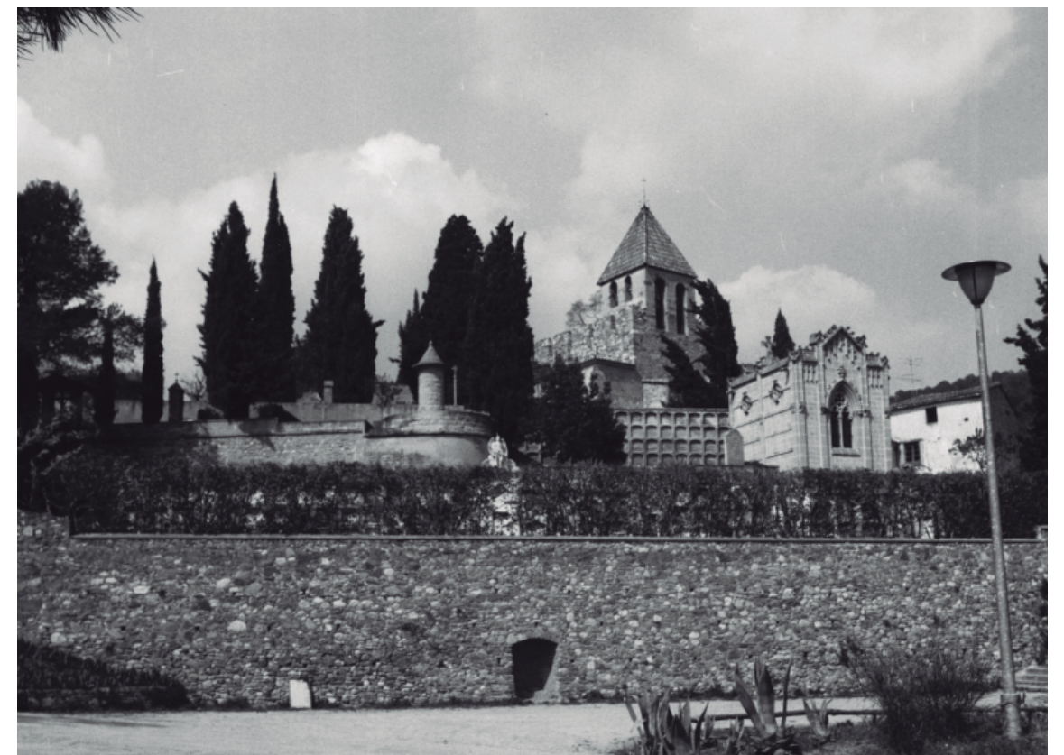
ADEQUACIÓ DE LA URBANITZACIÓ EXTERIOR DEL CONJUNT MONUMENTAL DE LA DOMA A LA GARRIGA ref. 1606
