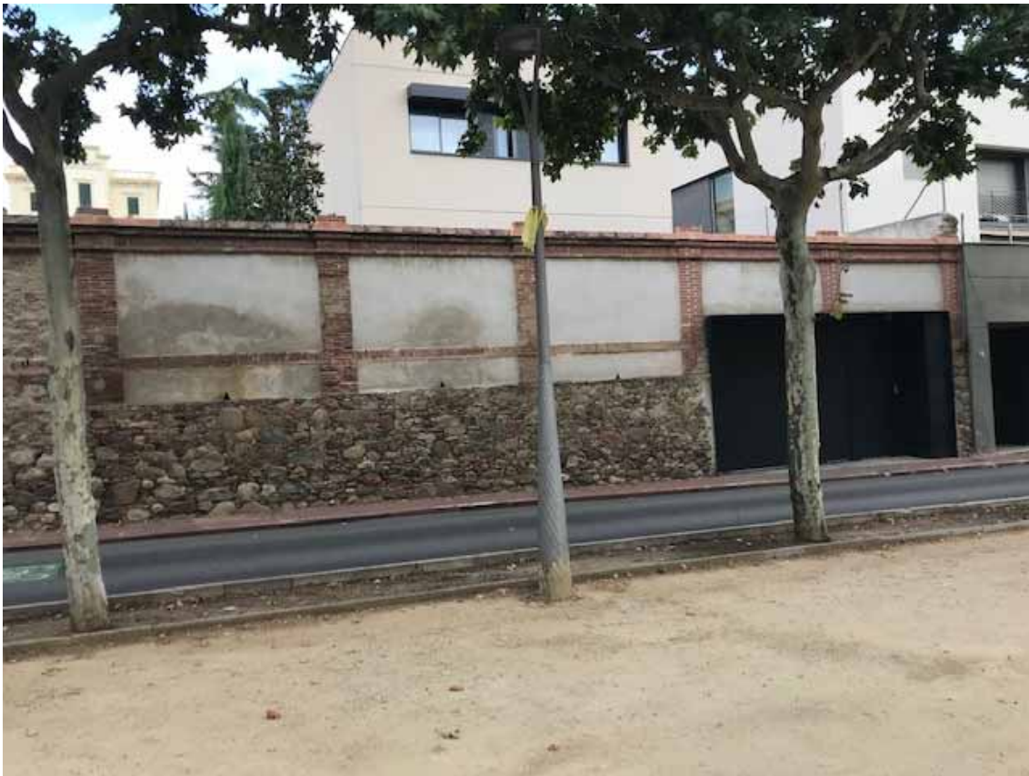
Reforma i rehabilitació de la tanca al tram corresponent a la finca del Passeig núm. 14 que es va dur a terme junt a la construcció d'un nou habitatge unifamiliar aïllat
