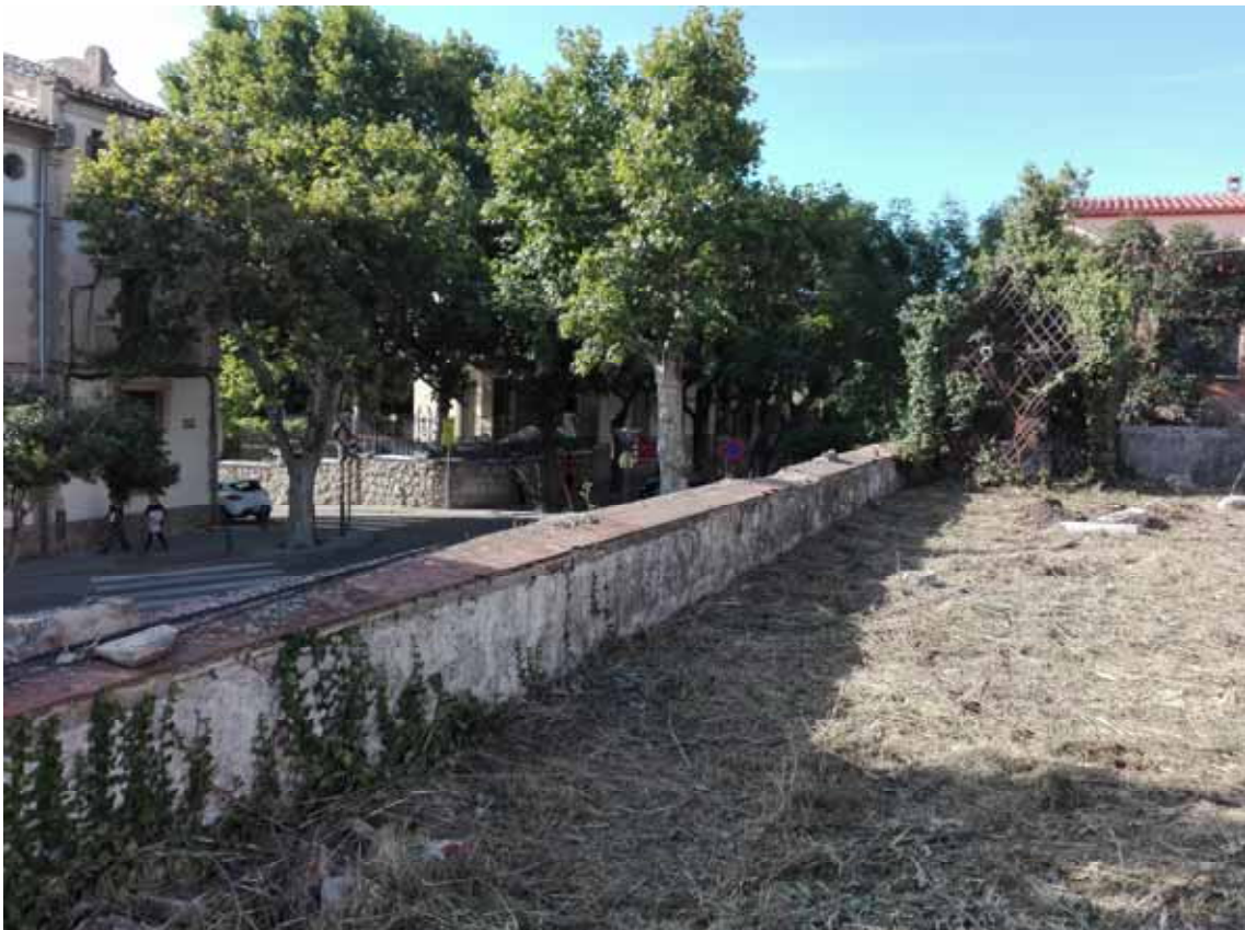
FOTO 8. Tanca interior amb el tram pla del Passeig. El terreny es rebaixarà fins que l'alçada interior doni suficient protecció (alçada igual o superior a 0,90 metres).
