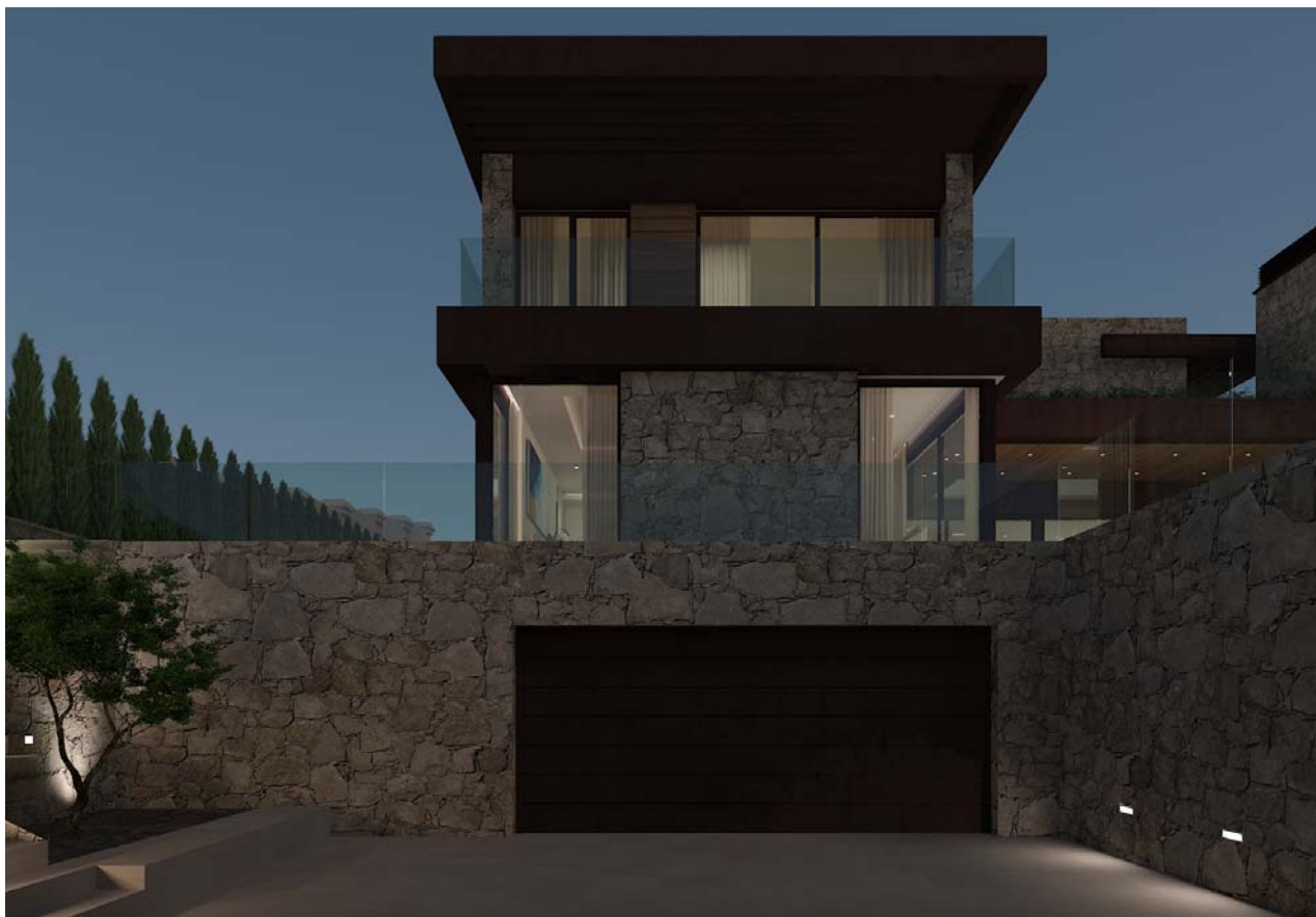
IMATGE 1. Façana oest des de rampa garatge
