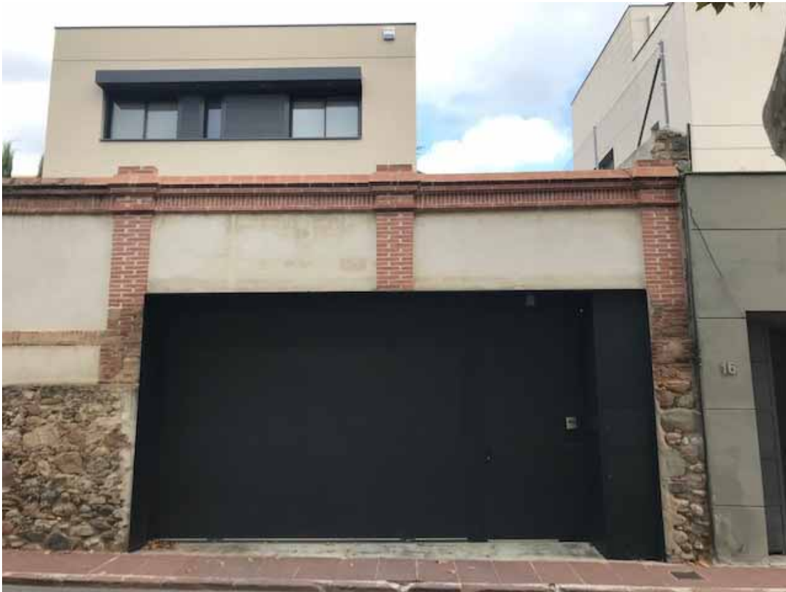
Detall de l'obertura practicada al mur del Passeig, detall del coronament i de la rehabilitació que es va dur a terme a la tanca al tram corresponent a la finca del Passeig núm. 14
