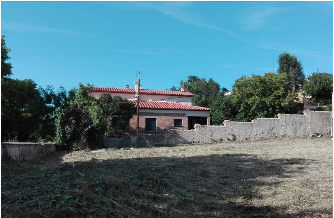
FOTO 2 Cantonada des de interior parcel·la
