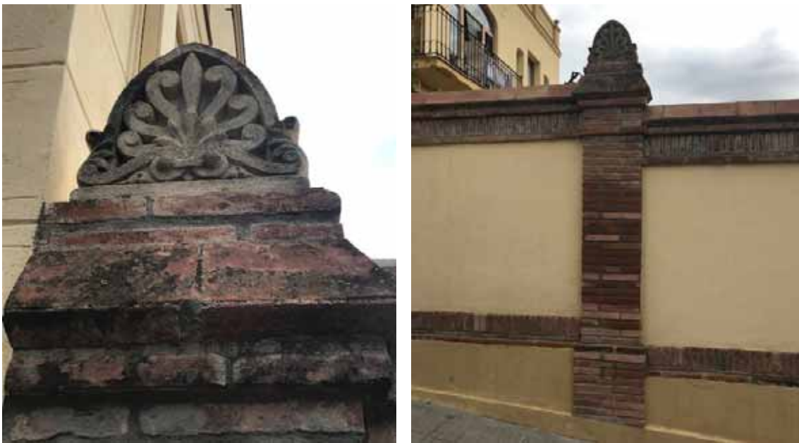
Detall dels pinacles de remat i un dels quatre pilars de la tanca restaurats al carrer Caselles
