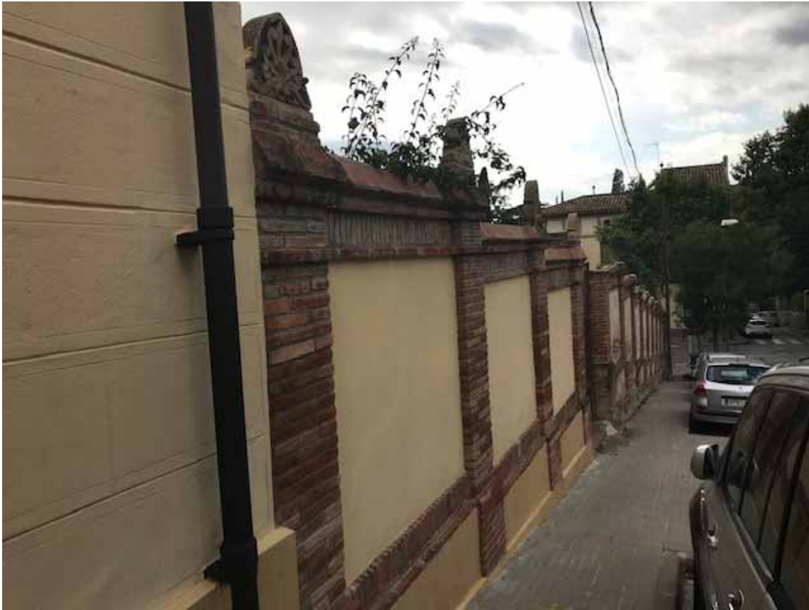
FOTO 1. Tanca del carrer Caselles. Els primers tres trams s'han rehabilitat.
